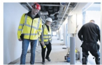
Culvane er færdige i flere af rummene. Så Jan Heston (ned nederst) er her ved at danke dem til, mens Claus Helmer Andersen, projektleder på Nyt OUH med ansvar for udførelse og brandtrykning, og Trine Jørgensen, planlægningskonsulent i SDCO, ser til. Foto: Michael Boger
